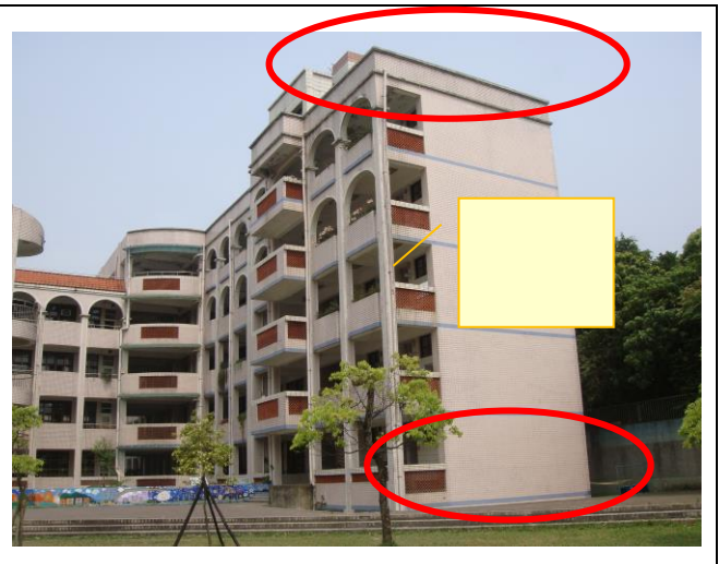
照片 6 說明：東昇樓回收筏基水塔設置點。
