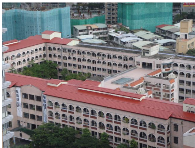
照片 1 說明：西華樓北安樓斜屋頂。
