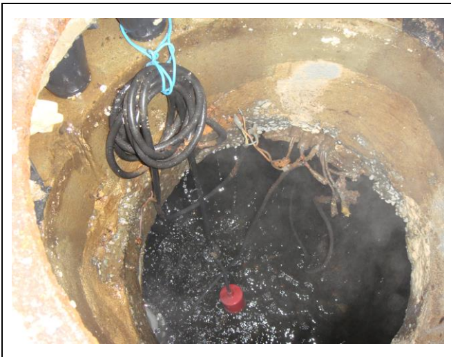
照片 5 說明：東昇樓地下室筏基水源。
