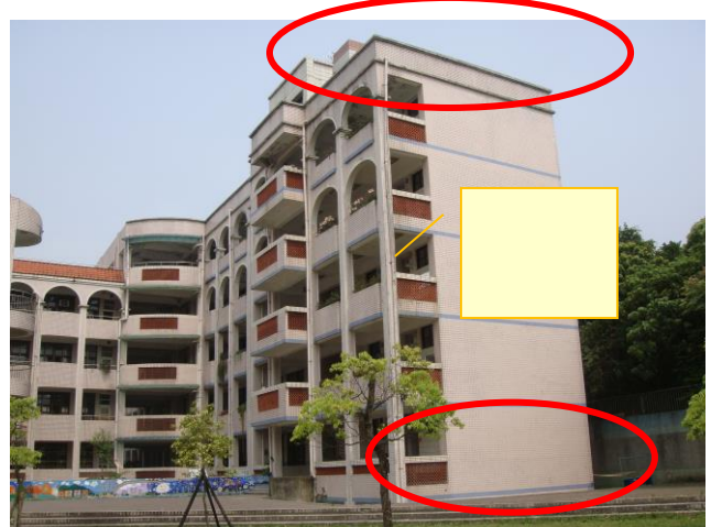
照片 6 說明：東昇樓回收筏基水塔設置點。
